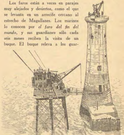
Construcción de un faro dentro del mar, asestando la fábrica en una roca. Desde un acantilado de la costa, por medio de cables, se trasladan los obreros y el material
