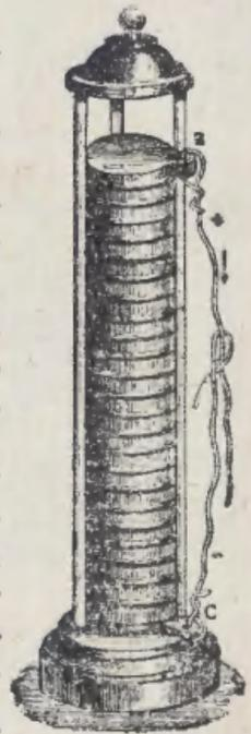
Pila de Volta
