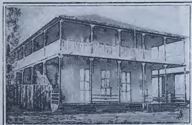
242. Escuela de dos aulas, en la Isabela.
