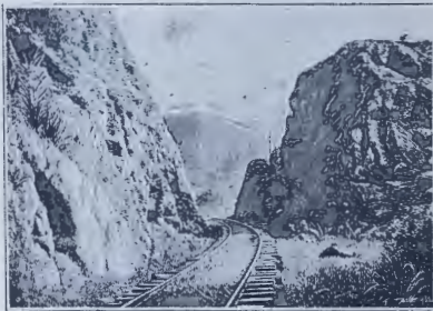
232. Excavación del ferrocarril de Santiago de Cuba.
