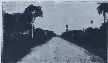
388. Carretera Central de Camagüey.
