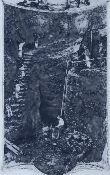
189. Extracción del asfalto, en el Maríel.
