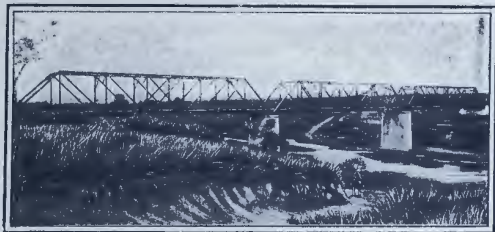
339. Puente de la carretera de Arimao.
