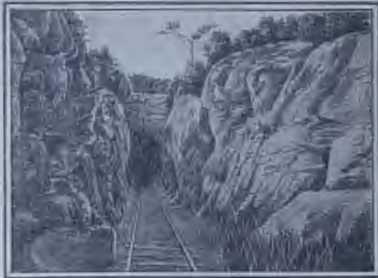
233. Túnel del ferrocarril de Gibara a Holguín.
