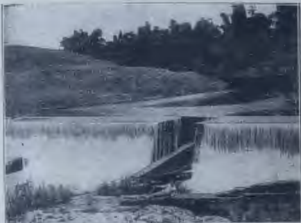
361. Acueducto de Sancti Spiritus.
