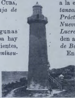
84 Faro del cabo San Antonio.
