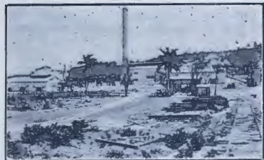
271. Fábrica de cemento del Mariel.
