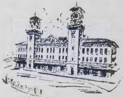
Estación Central de Ferrocarriles, Habana.
