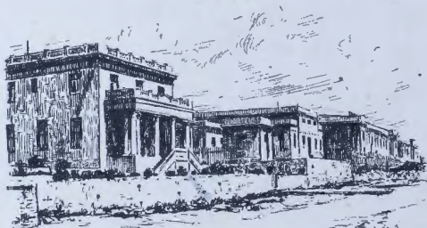
Vista parcial del Hospital Nacional, Gral. Calixto García.
