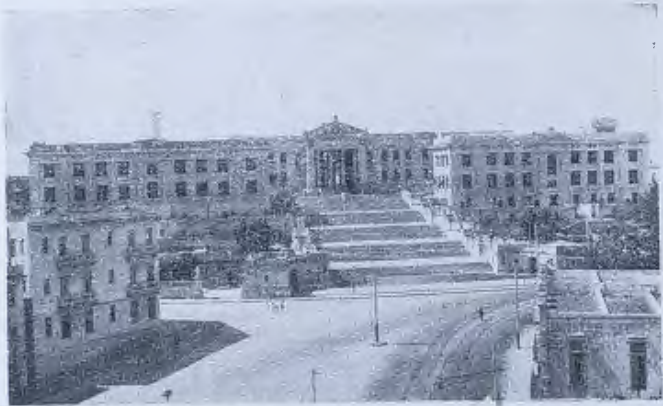
Gran escalinata y jardines de la Universidad, construídos durante el Gobierno del Gral. Machado.
