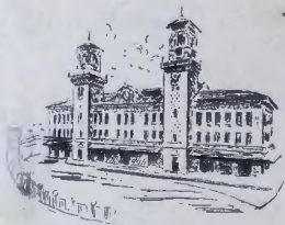
Estación Central de Ferrocarriles, Habana.
